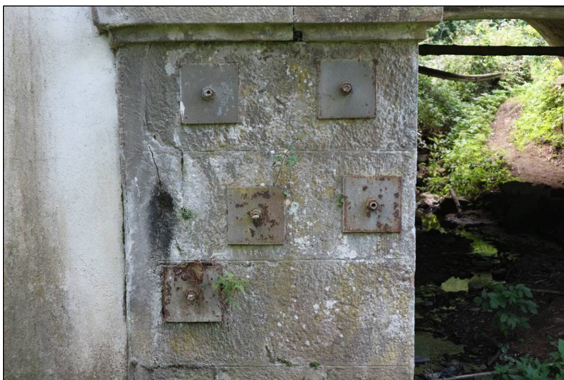
Obr. č. 5 - pohled na čelo opěry Adamov, zprava - detail zhlaví ocelových táhel
