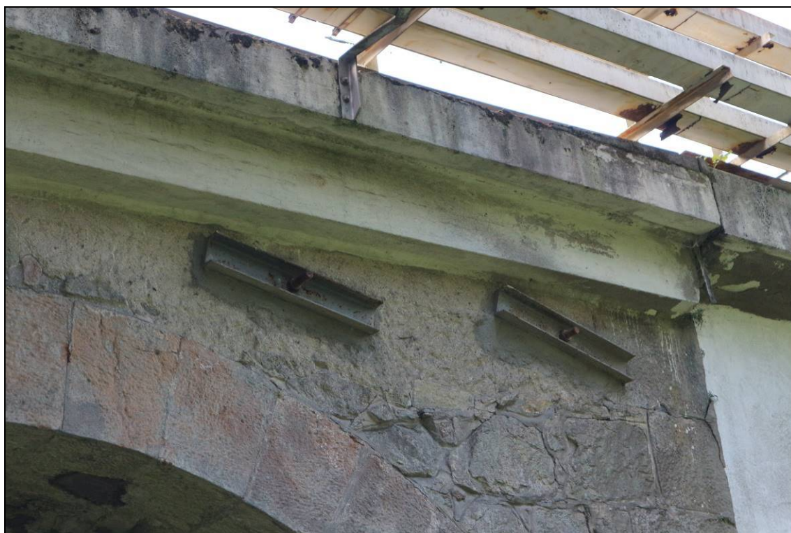
Obr. č. 6 - pohled na čelo objektu, zprava - detail zhlaví ocelových táhel
